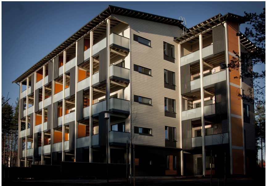
Kuva 1 PuuEra on Suomen ensimmäinen yli nelikerroksinen puukerrostalo.
