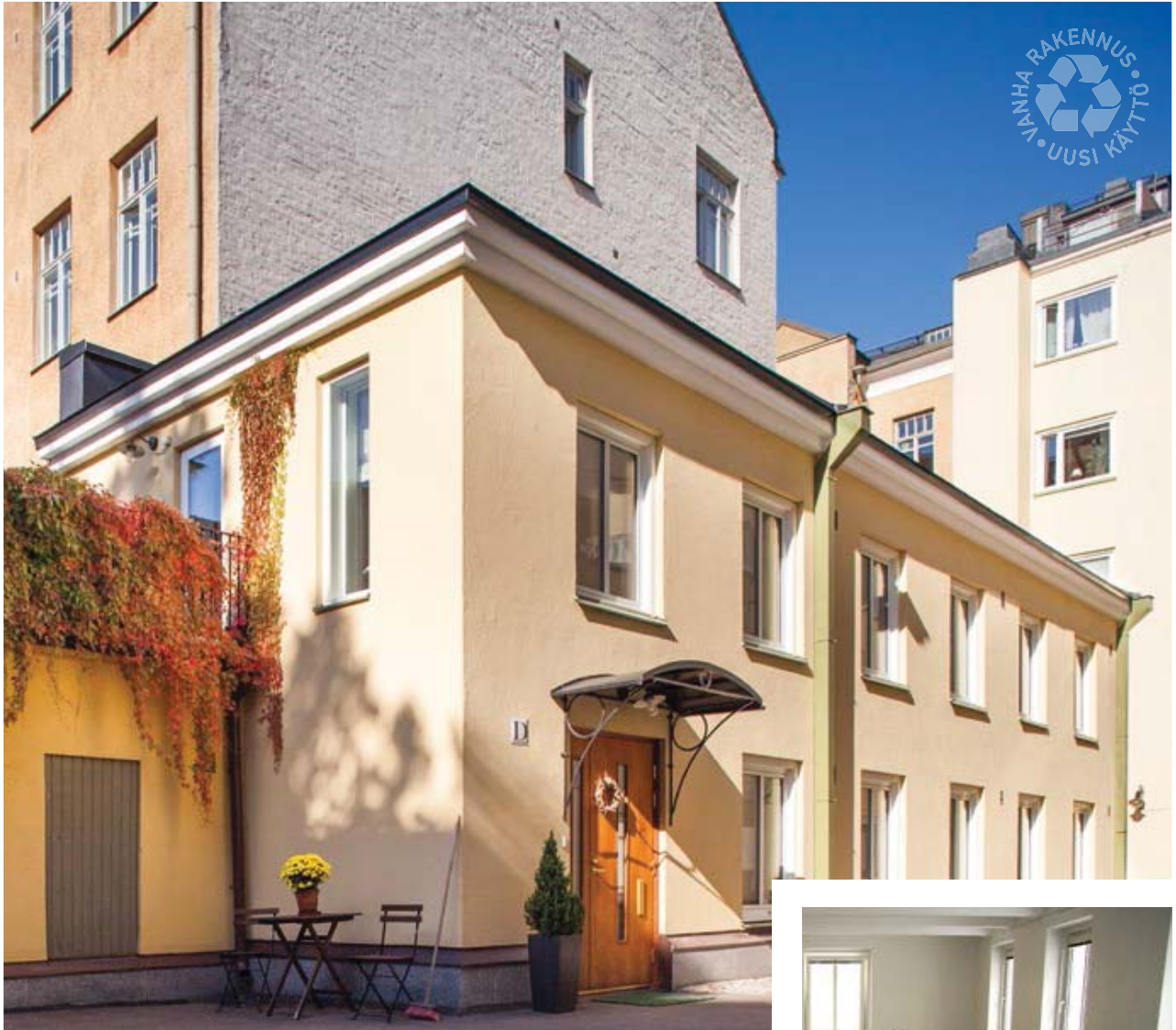
Lähes 60 vuotta vanha piharakennus Helsingin Ullanlinnassa on muuttunut moderniksi asunnoksi. Peruskorjauksessa kaikki meni uusiksi paitsi aikaa kestäväät seinien ja lattioiden kivirakenteet.
