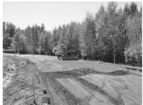
Kuva 6. Betonimurteen käyttöä tienrakentamisessa.
