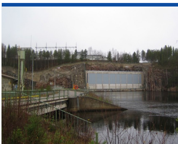
Pirttikosken tunnelivoimalaitos valmistui Rovaniemelle vuonna 1959. Se louhittiin kallion sisään, jotta saatiin tarpeeksi putousta. Suuret rakennukset koneistoiheen toimivat kauko-ohjattuina Rovaniemeltä käsin.
