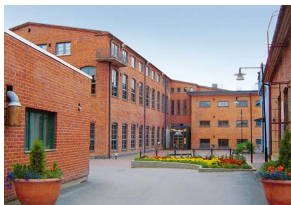
Muuntojoustavuus on uuden rakentamisen keskeisiä kehityssuuntia. Valtion patruunatehtaan alue Lapualla on muutunut arvokkaaksi kulttuurikeskukseksi asiantuntevalla ja perinteitä kunnioittavalla korjausrakentamisella.
