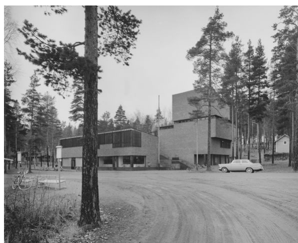
Alvar Aallon suunnittelema ja vuonna 1952 valmistunut Sääntäsalon kunnantalo on monitoimirakennus, jossa on ollut niin kunnanhallintoa, kirjasto kuin myös asuntoja, liiketiloja ja vierashuoneita. Kokonaistaideteoksen viimeistelevät juuri tähän rakennukseen tarkoitetut huonekalut.
