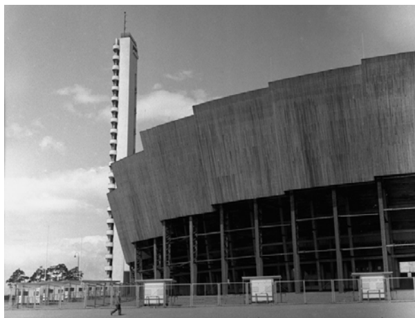
Helsingin Taka-Töölössä sijaitseva olympiastadion valmistui jo vuonna 1938, mutta maailmansodan vuoksi toimi kisapaikkana vasta 1952.
